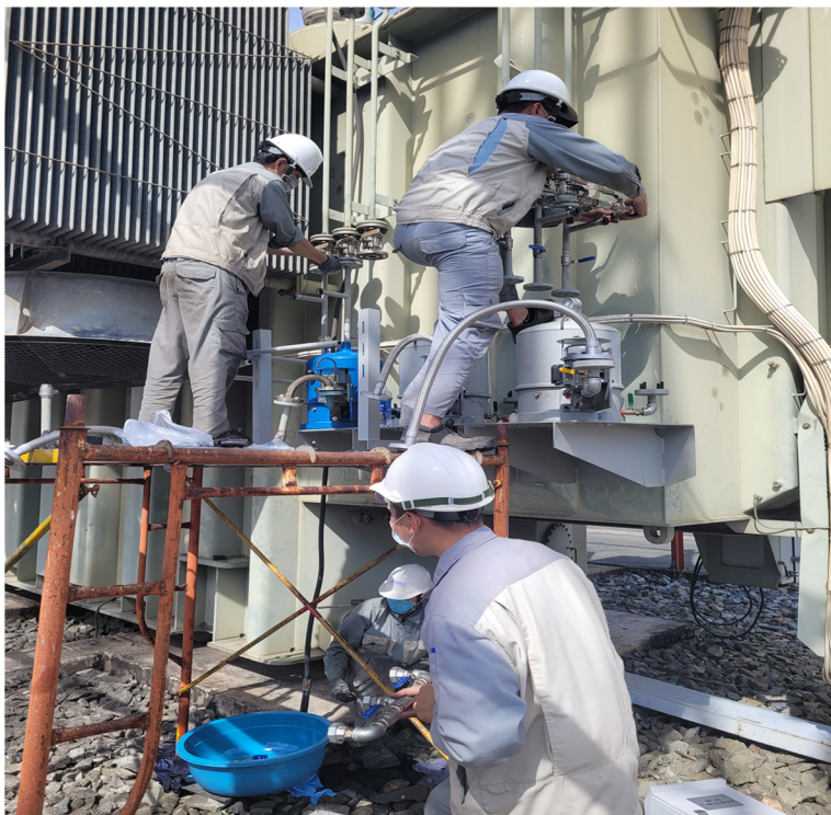
電力変圧所向オイル冷却タンクの取付作業
