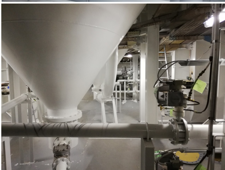
セメント輸送設備の取付作業
